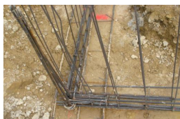
Nœud de chaînage - Continuité mécanique
