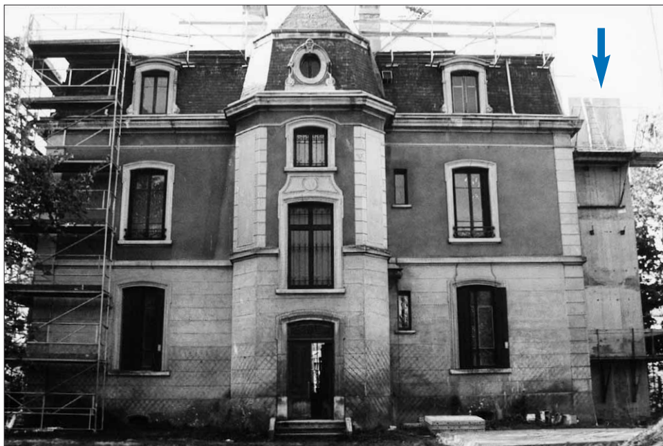
Un escalier d'accès a été apposé sur la façade Nord.
