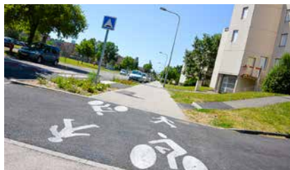
Aménagement d'une voie de circulation douce boulevard des Allées fleuries.
