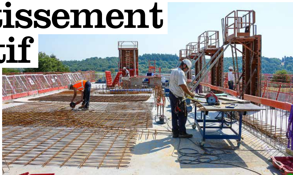
CCVG: Chantier du centre aquatique
