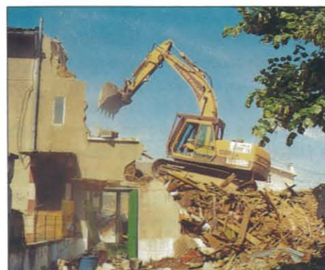
La démolition de l'îlot situé face à l'Hôtel de Ville, conduite de main de maître, a laissé place au chantier exemplaire de la résidence Côté Parc.
