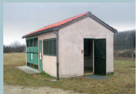
Puits de captage situé à proximité des Sept chemins
