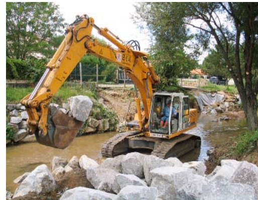
Après les travaux « post crue », le SMAVG va procéder aux aménagements de protection contre les inondations trentennales.
