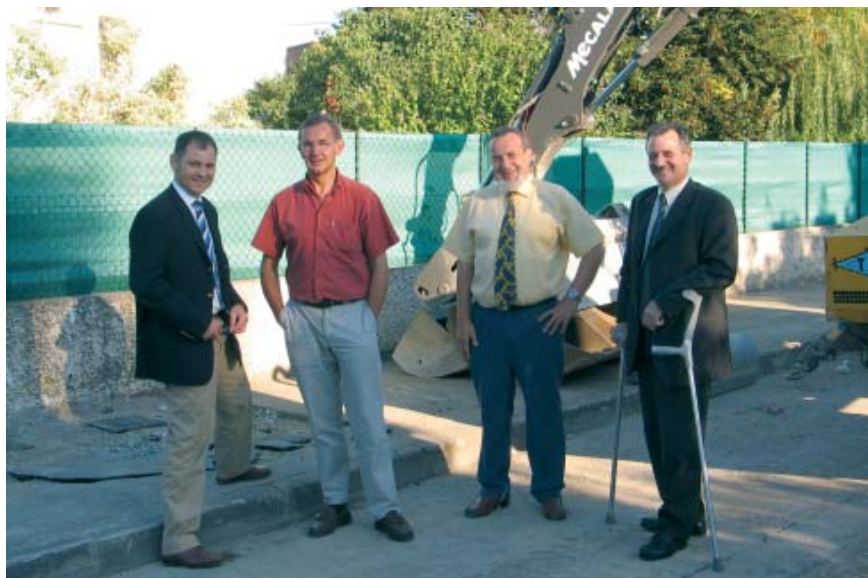
Les Conseillers municipaux sur les travaux d'assainissement de la rue F. Gaillard (coût : 344 675 euros). De gauche à droite : Paul Laurent, Dominique Viret, Jean-Louis Imbert et Ernesto Fernandes.
