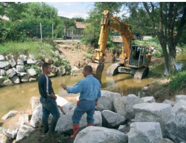
Au pont André Lassagne : curage du lit de la rivière et reconstitution de l'enrochement de la berge.
