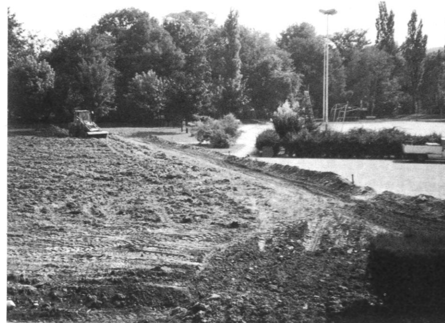
Les travaux de réfection du stade municipal.
