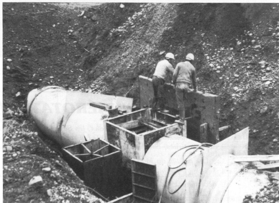
La pose d'une canalisation en Zone Industrielle Sud.
