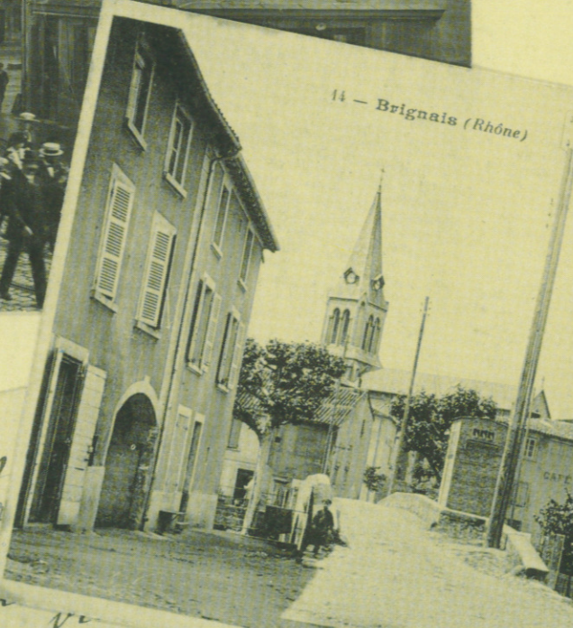
Le vieux Pont et l'Eglise
