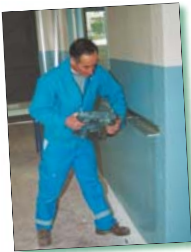
Paul sur le chantier des ateliers municipaux.
