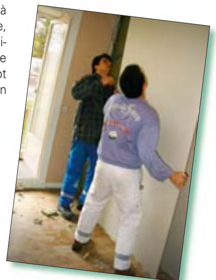
James et Noël montent une cloison afin de créer une pièce supplémentaire dans l'appartement d'un gardien.
