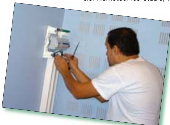
Serge est en train de monter toute l'installation électrique pour l'extension de la bibliothèque.
