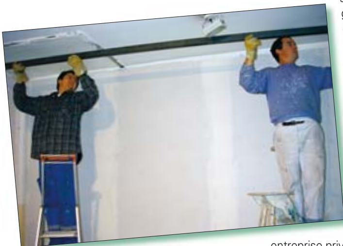
James et Noël installent un faux plafond.
