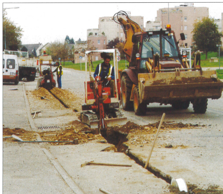
Chantier de passage en souterrain du réseau.
