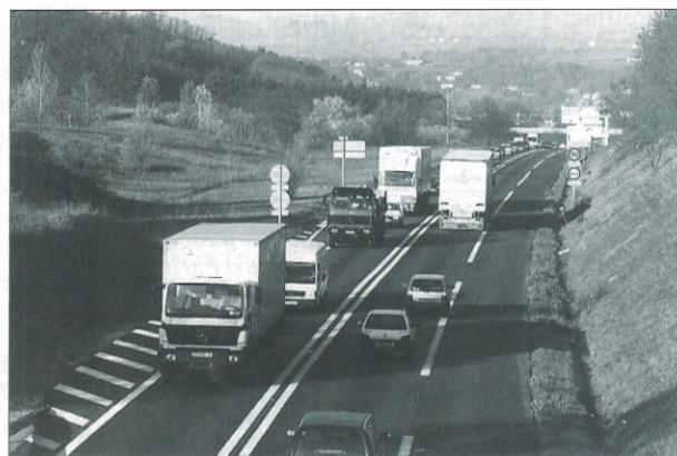
C'est en 1993 que le principe de la création de l'autoroute à péage Lyon/Saint-Étienne a été adopté : une liaison classée d'intérêt social et économique, au regard de la saturation de l'A47 et de la nécessité de désenclaver certains territoires de la Loire.
