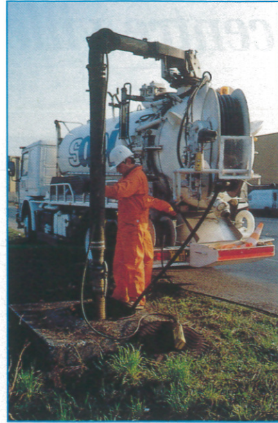
Maintenance des réseaux
