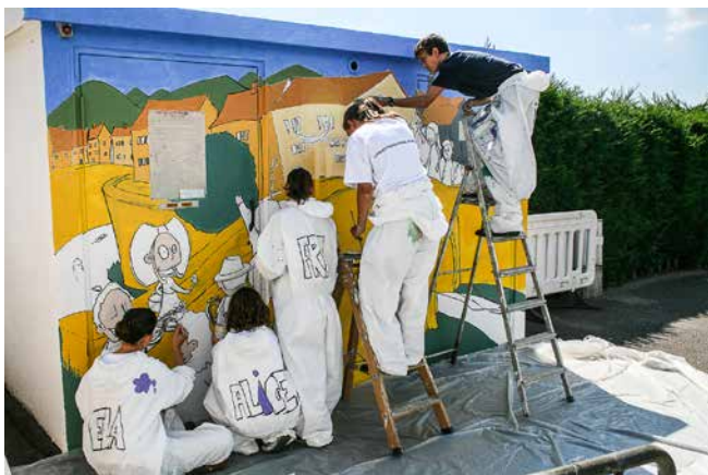
Chantier européen jeunes à Brignais, en août 2010: transformateur situé face au Briscope
