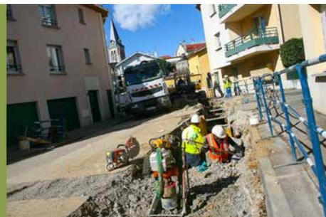
La qualité de l'eau en point de mire des travaux de mise en séparatif du réseau d'assainissement dans le centre de Brignais
