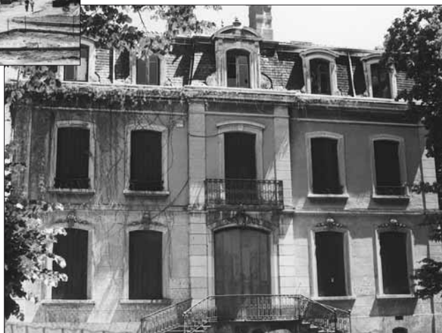
Les travaux de la future Villa des Associations démarrent cet été.
