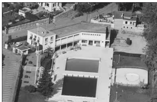
La 2 e tranche de rénovation de la piscine est annoncée.
