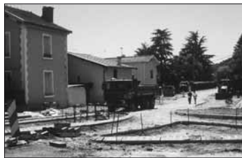
La rue du Garel en travaux.
