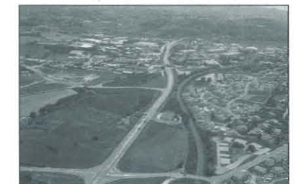
RD 42 : après la phase légale d'enquête publique (avril 94) les Brignairots devront encore patienter quelques mois avant le démarrage des travaux.
