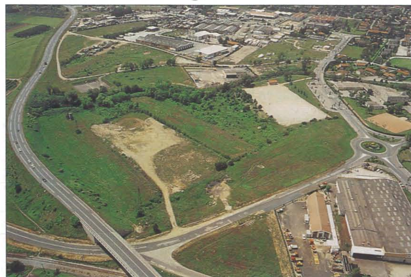
L'arrivée d'une unité GDF sur le site du Gaud fait partie d'un vaste plan d'investissement en Rhône-Alpes lancé par l'entreprise en 1994 à hauteur de 3,9 milliards.
