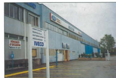
Pose d'automatismes. Installations industrielles et suivi de maintenance (Sotis et Iveco).
