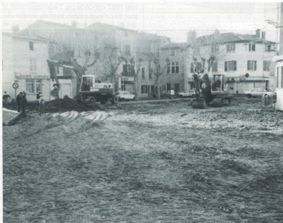
Les travaux place Gamboni.
