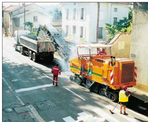
Démolition de la chaussée : un travail à la chaîne
