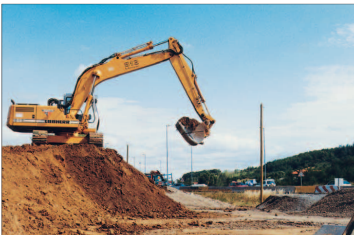
Le doublement de la RD42 s'articule avec la réalisation de l'A45 par l'État, projet inscrit au contrat de plan État / Région, 2001 / 2006.
