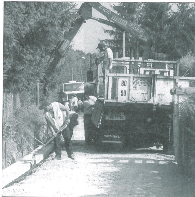
Le montant total des travaux de voirie s'élèvera à 2,3 MF, soit 1,3 MF d'appel d'offres, 0,5 MF de marchés sur bons de commandes et 0,5 MF pour le marché d'entretien.
