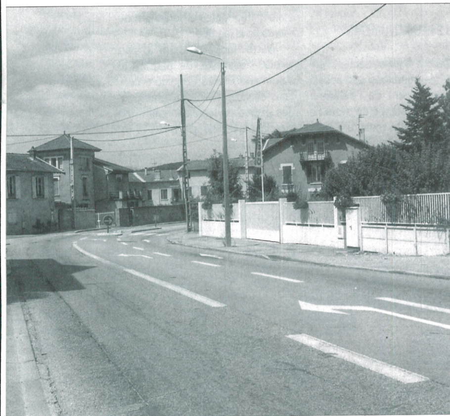
Réaménagement des trottoirs de l'entrée Est de la Ville.
