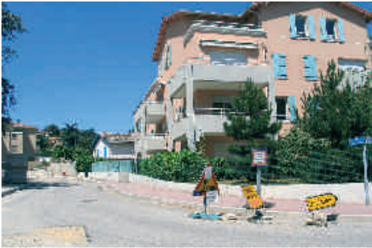
Les travaux de la rue de Janicu se termineront mi-juillet
