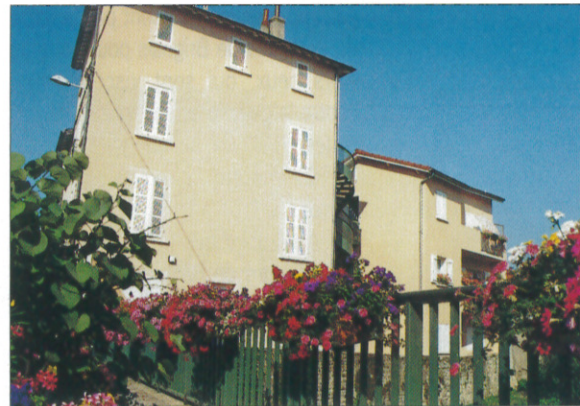
Immeuble le Pont Neuf : un exemple de réhabilitation en centre ville (Opac du Rhône).
