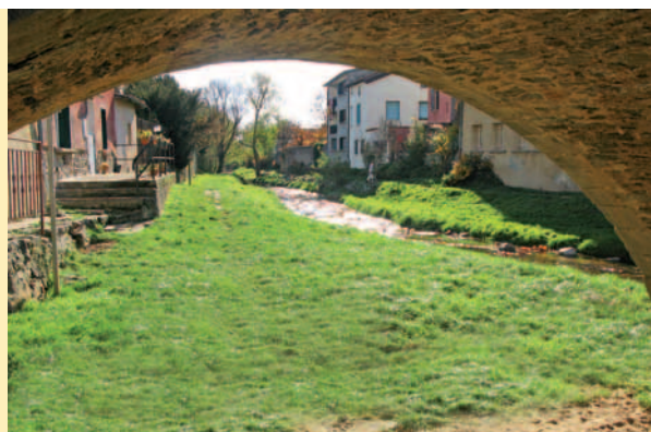
Promenade des deux ponts
