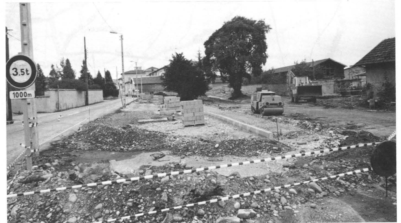
Les travaux d'élargissement de la rue Bovier-Lapierre.
