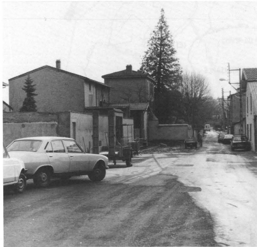
Elargissement de la rue du Moulin.
