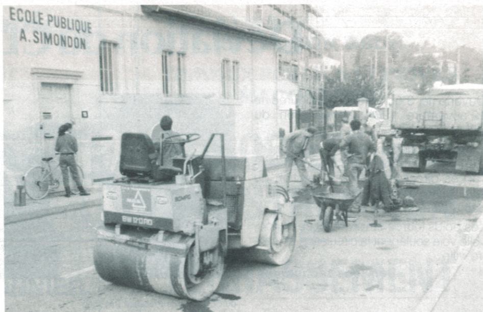
Rue Simondon devant le groupe scolaire, mise en place de deux ralentisseurs.
