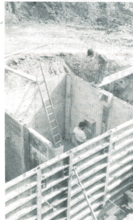
« Travaux piscine ». Mise en conformité. Construction d'une bache de récupération des eaux de goulottes.
