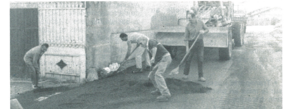
Travaux de voirie.
