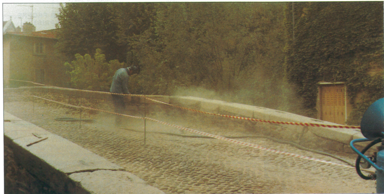
Une vaste rénovation a été entreprise pour conserver ce témoin de l'histoire.
