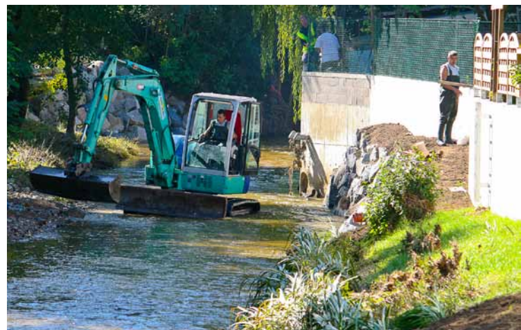
Protection contre les crues trentennales à la Garonette
