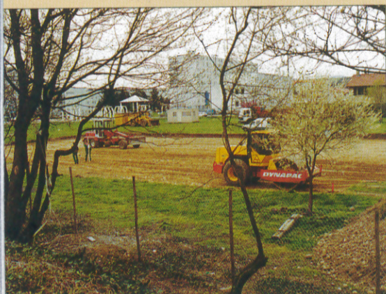
Le chantier du nouveau gymnase.
