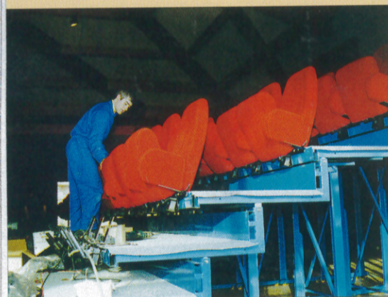
Le Briscope pendant l'installation des gradins.
