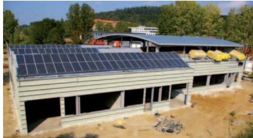
**Un bâtiment HQE : 144 panneaux photovoltaïques (soit 130 m<sup>2</sup>) ont été installés sur la toiture**
