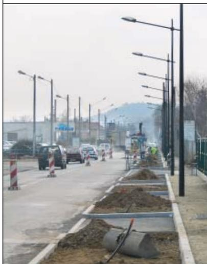
■ Après l'enfouissement des réseaux secs (éclairage, EDF, France Telecom et le câble), la seconde phase des travaux est lancée. Elle consiste en l'aménagement de la voirie avec la reprise des trottoirs, la création d'une piste cyclable, l'agencement d'espaces verts et le renouvellement de l'éclairage public. La Communauté de communes de la vallée du
