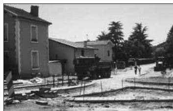
La rue du Garel en travaux.
