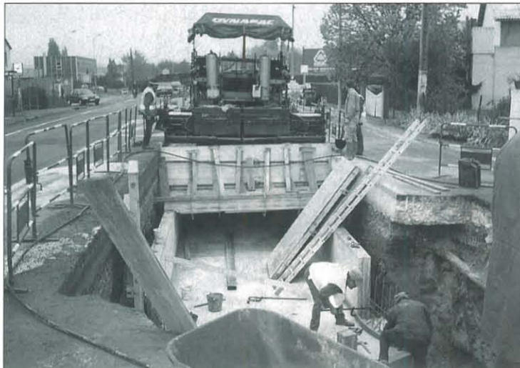
Le Conseil Général a financé pour partie les travaux hydrauliques de recalibrage du Merdanson.
