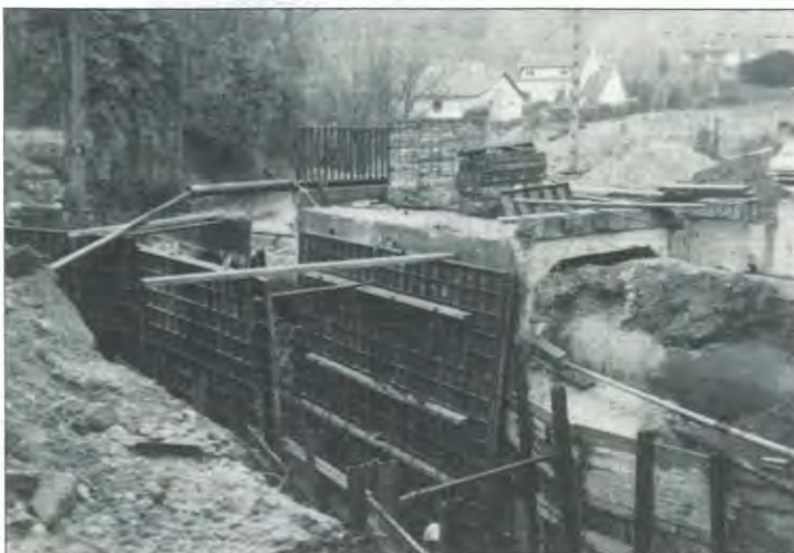
Plus de 7 tonnes d'acier et quelque 80 mètres cubes de béton ont été utilisés pour réaliser la totalité de l'ouvrage.
