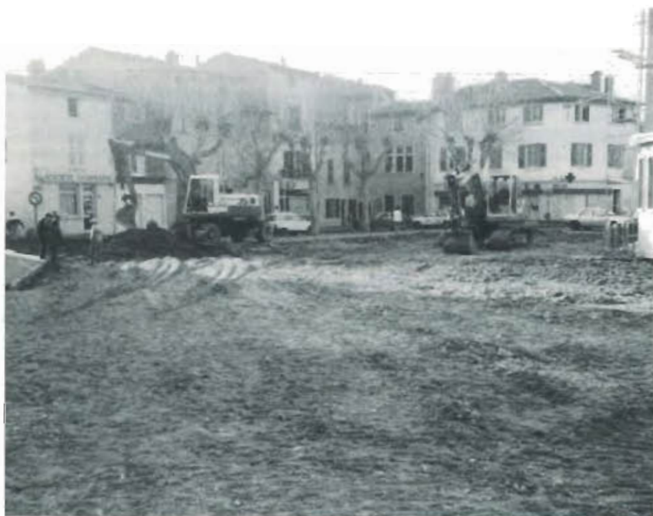
Les travaux place Gamboni.
