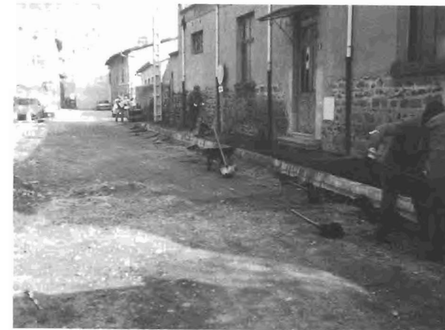
Réfection de l'avenue de Verdun.
