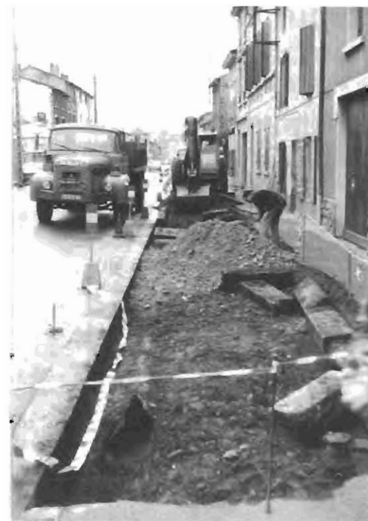
Aménagement de trottoirs.
