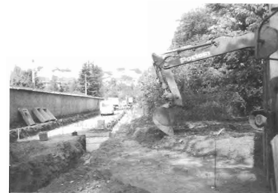
Le chantier de la rue de Janicu.
