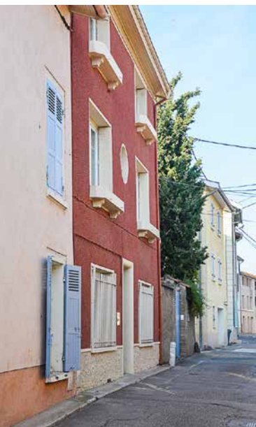
La réfection de la rue de la Giraudière, en lien avec la CCVG, est prévue courant 2020.
