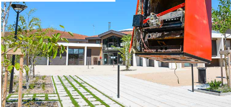
Enlèvement de l'ancienne chaudière du Briscope
