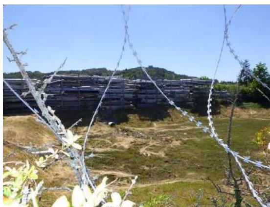
Bassin de rétention - vue depuis le chemin de la Fonderie
