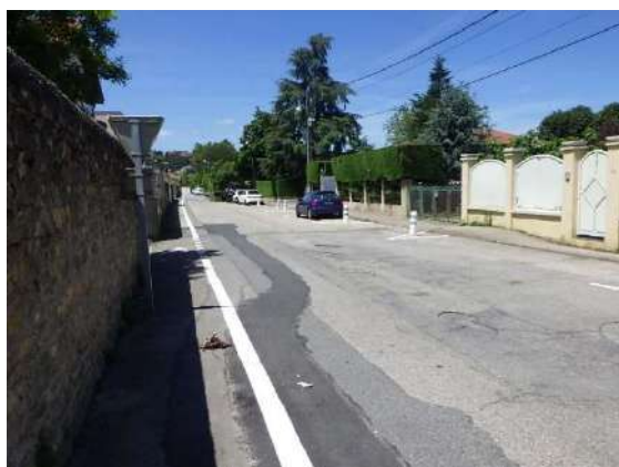
Rue du Presbytère – vue vers l'ouest
